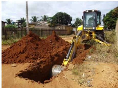
**Figure 150 - exemple de dispositions des déblais au niveau des tranchées (Source : rondoniagora.com)**
