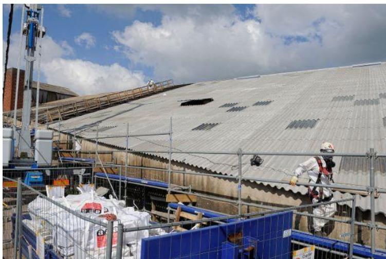
***Vue d'ensemble d'un chantier de retrait d'une toiture amiantée, avec le stockage intermédiaire des déchets au premier plan (source INRS)***
