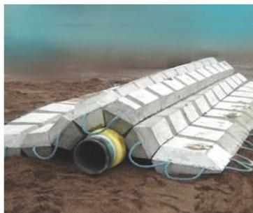
Figure 100 - Matelas en béton
