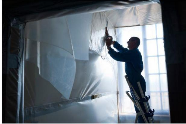
***Pose de plastique pour délimiter une zone de confinement sur un chantier de retrait d'amiante (source INRS)***
