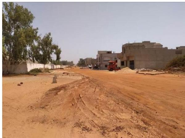
**Photo 71 - Route latéritique réalisée par Elecnor (SOFRECO/EGIS, 2022)**
