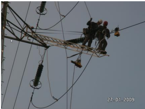
Photo 1 : Travaux sur les pylônes
