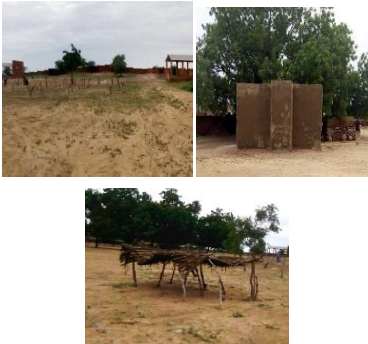
Photo 32: Hangars et Latrines en matériaux définitifs et Mosquée en banco et hangar en paillote sur le site de Guidan Roudji
