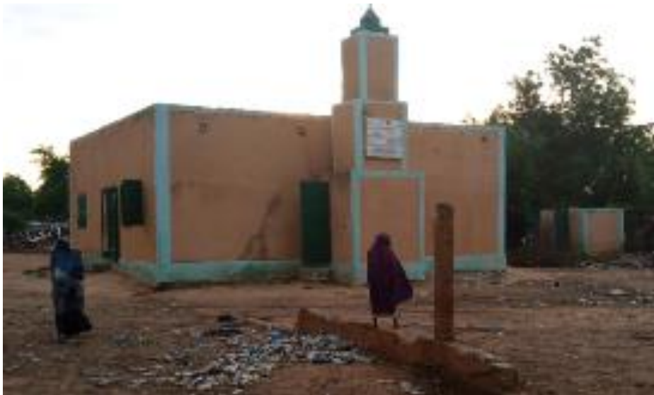
Photo 30: Mosquée construite en matériaux définitif
