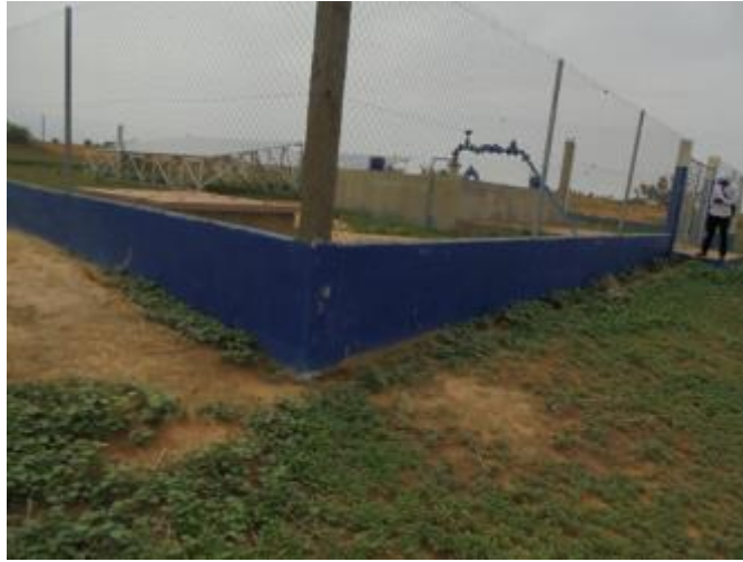
Photo 11 : Aperçu d'un forage et station de pompage solaire du village de FALMEY
