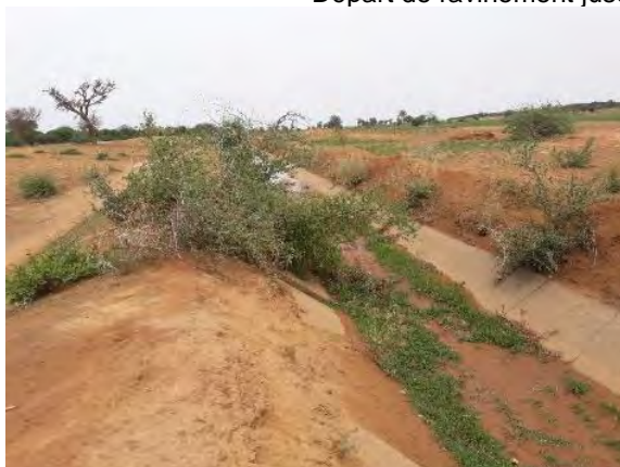
Sédimentation récurrente du canal liée au ravin
