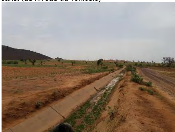
Sédimentation récurrente du canal liée au ravin
