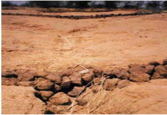
Photos 2 : Ligne de diguette en pierres sèches
