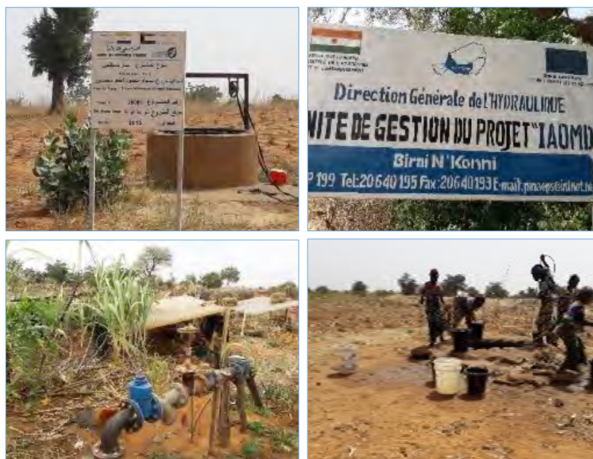
Photos: 2- Systèmes d'alimentation en eau potable des villages : Puits traditionnel, puits amélioré et autres forages exécutés par des projets
