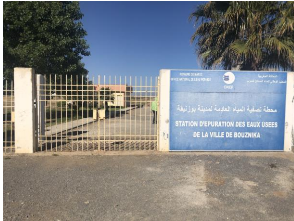
Entrée de la STEP de Bouznika
