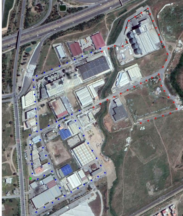
Figure 47 : Représentation du réseau d'éclairage public au niveau de la Zones industrielle de Bouznika
