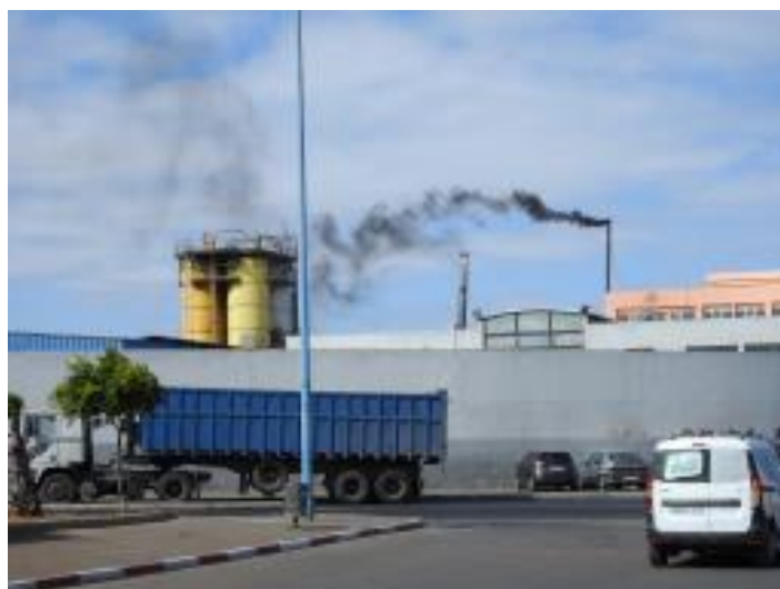
Figure 5-4. Panache visible des émissions des chaudières (vue depuis le CTRD)
