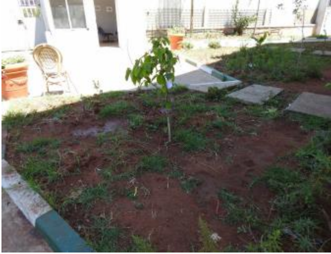
موقع إنشاء محطة تصفية قبلية لمياه الصرف الصحي
