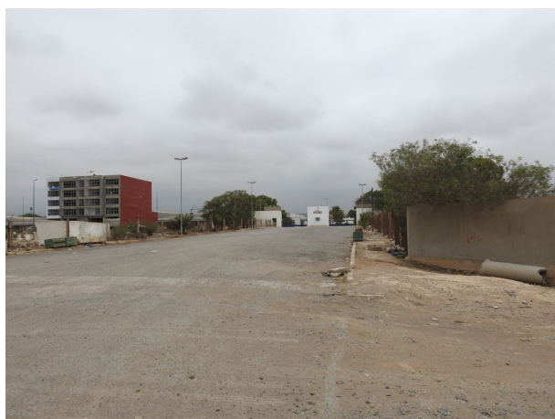
Bâtiment en cours de construction (1)
