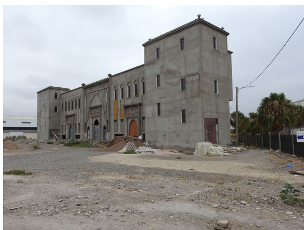
Une mosquée en cours de construction
