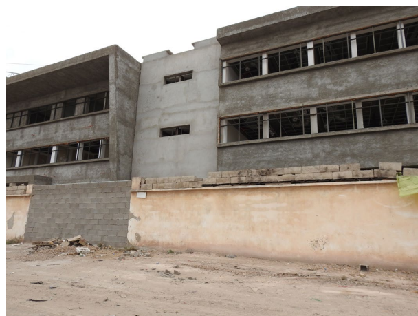
Bâtiment en cours de construction (2)
