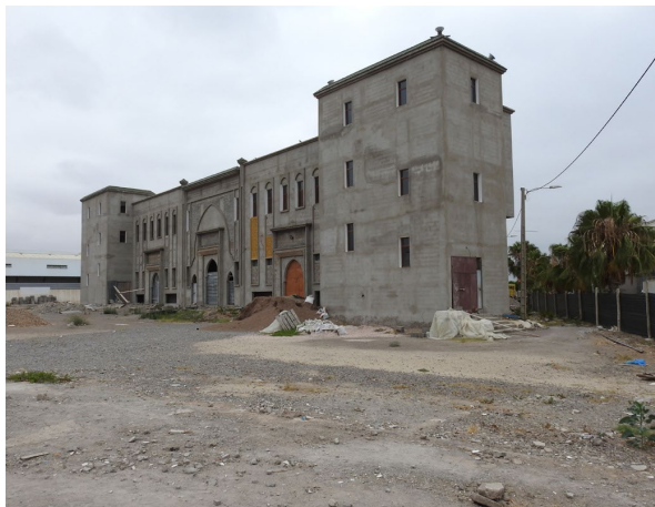
Mosquée en cours de construction au sein du lotissement
