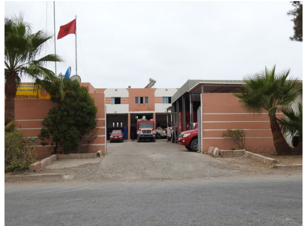
Caserne de pompiers
