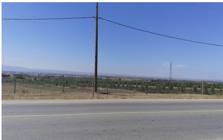
Figure 7.19 : Ligne électrique de 22kV
