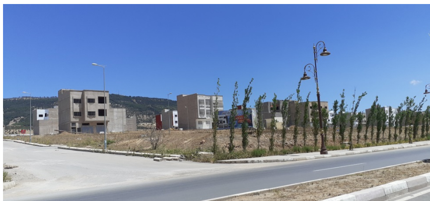
Figure 7.13 : Quartier résidentiel en cours de construction riverain
