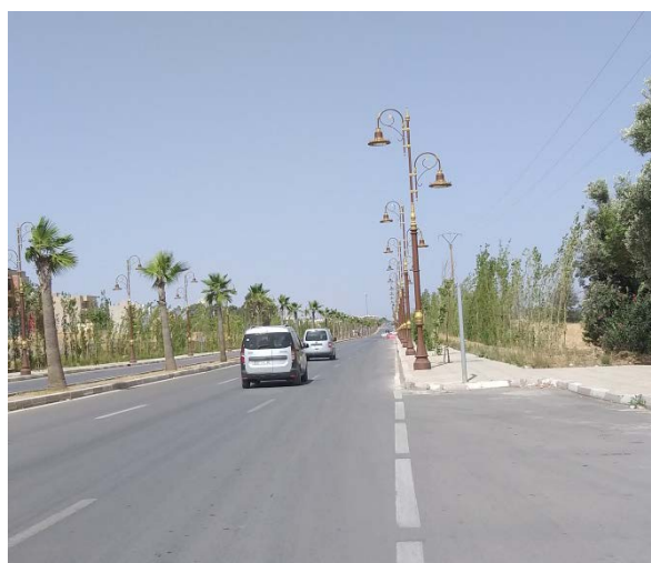
Figure 7.18 : Vue de la route nationale 6 en 2X2 voies au droit de l'UEMF
