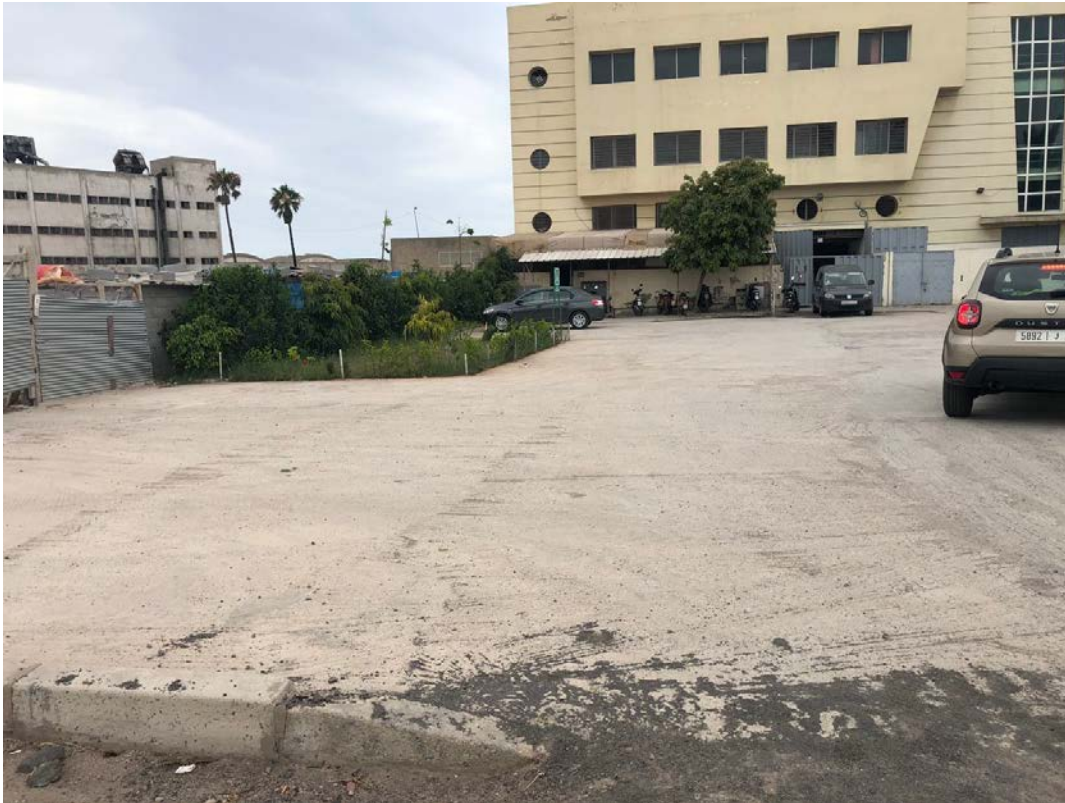
Figure 7.7 : Site du projet sur la partie Est (revêtement béton sur une partie)
