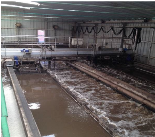
Figure 3-13 : Dessableur-déshuileur combiné type longitudinal
