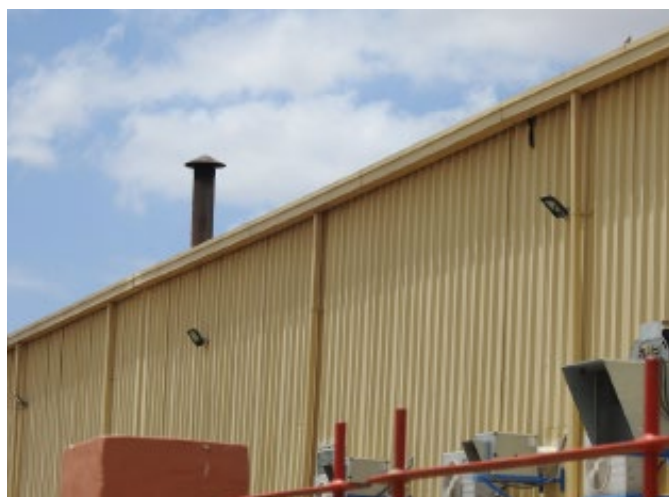
Figure 5-6 : Cheminée d'une unité industrielle existante sur la zone
