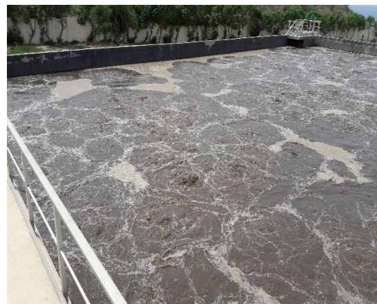
Figure 3-14 : Bassins à boues activées en fonctionnement
