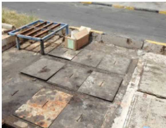
Dispositif de prétraitement d'une unité de production agro-alimentaire
