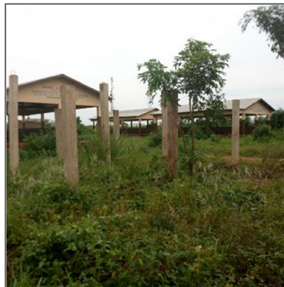
Photo 2 : Infrastructures d'un marché non utilisé (AECOM, octobre 2018) 5
