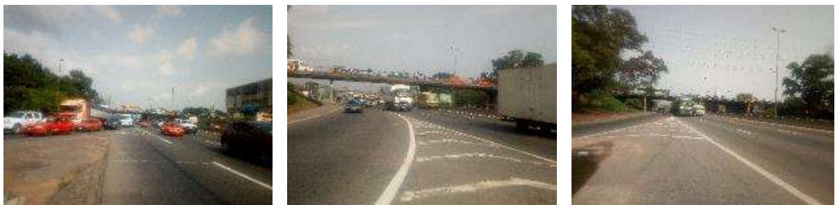
Figure 93 : Vues de quelques intersections du boulevard Yopougon Express (source : Egis, 2020)
