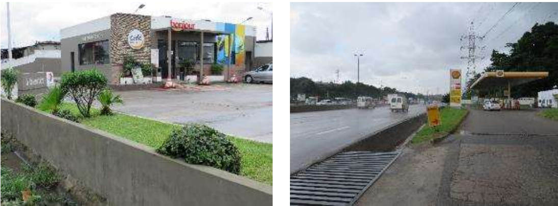
Figure 113 : Vues de stations-service aux abords de Yopougon express (source : Egis, 2020)
