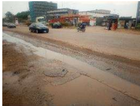
Eaux usées des industries sur le boulevard
