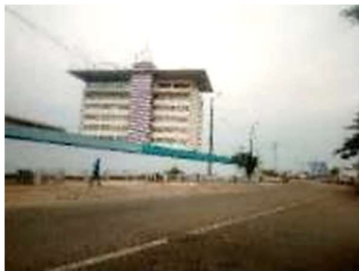
Administration du port
