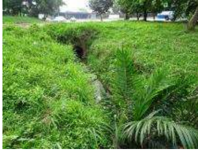
Figure 41 : Fossé végétalisé dans un délaissé du Yopougon Express (source : Egis, 2020)
