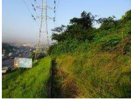
Figure 46 : Crête de talus, interface avec la forêt dense (source : Egis, 2020)
