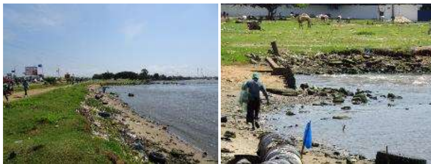
Figure 51 : Passage du boulevard Valéry Giscard d'Estaing sur la Baie de Vridi (Ebrié) et détail des buses (source : Egis, 2020)
