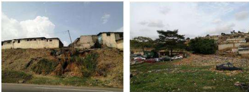
Figure 158 : Érosion (à gauche) et coulée de boue (à droite) (source : Egis, 2020)
