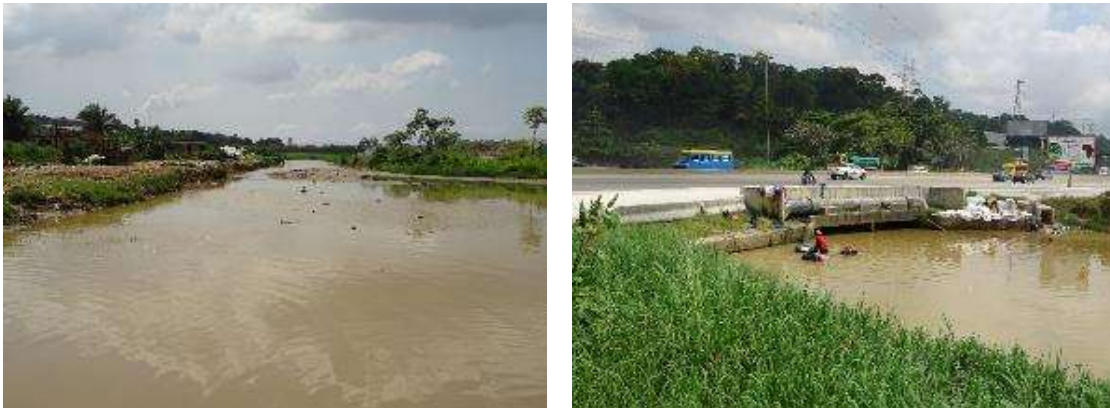
Figure 35 : Vues de l'exutoire de la Rivière Banco (source : Egis, 2020)
