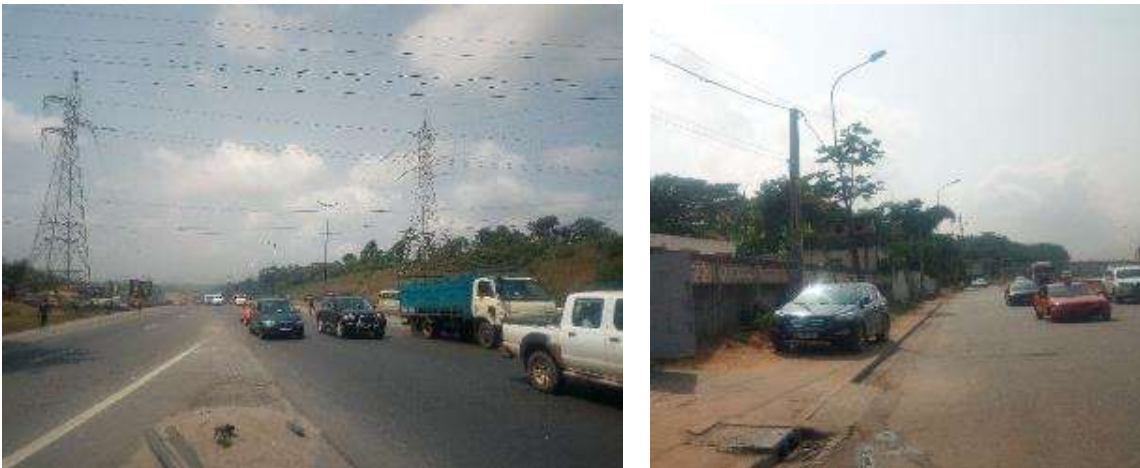
Figure 104 : Vues de pylônes avec lignes à haute tension (à gauche) et éclairage public avec lignes à basse tension dans le secteur du Boulevard de la Paix (source : Egis, 2020)
